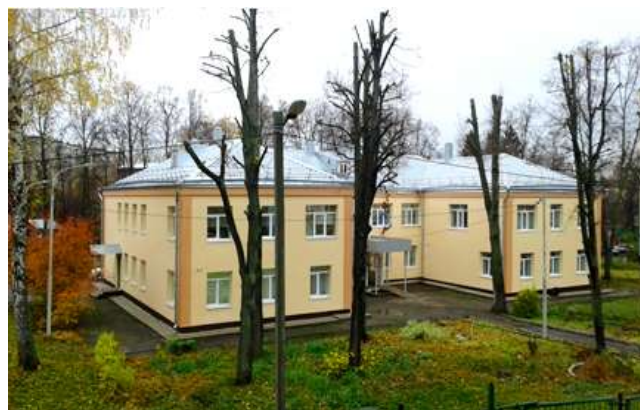
Второе здание ул.О.Кошевого 2а
